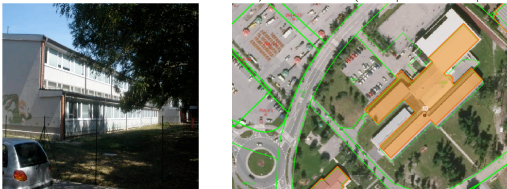
Slika 5: Osnovna šola Antona Globočnika Postojna – Matična šola (slika in prikaz stavbe v prostoru).
